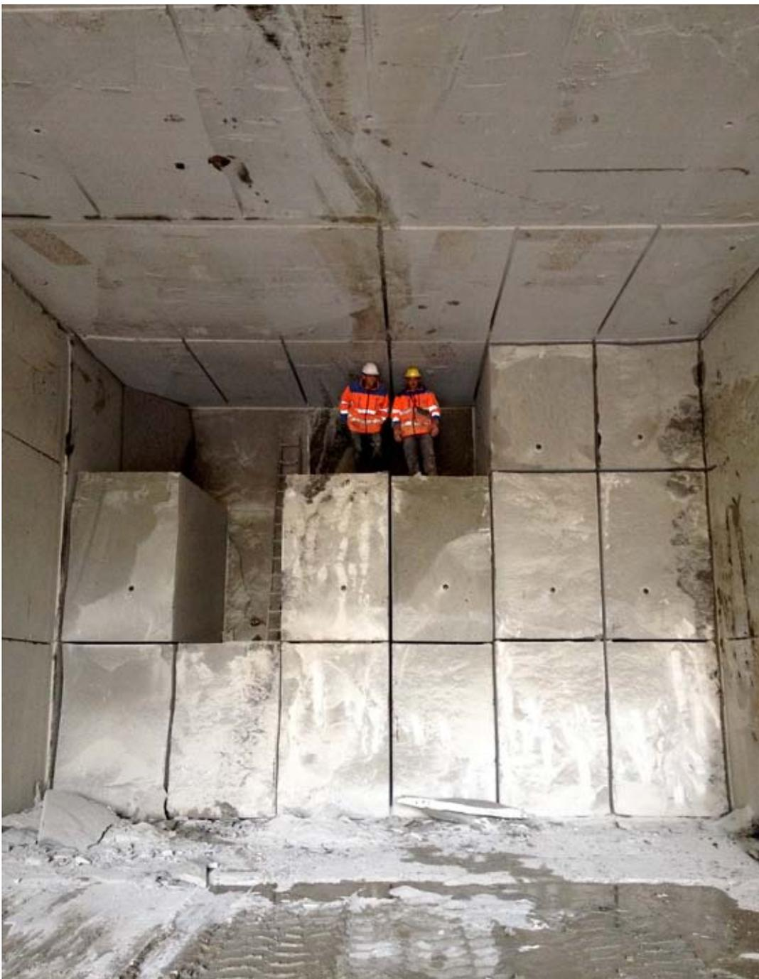
ten Blöcke mit einem Kran auf das Niveau des Stollens gehoben und mit dem Radlader ins Freie transportiert. Ein Derrickkran mit einer Ausladung von 40 Metern und einer Tragkraft von 30 Tonnen hebt sie schliesslich auf das Niveau der Steinbruch-Erschliessungsstrasse, wo sie auf LKW verladen und mit diesen in die Verarbeitungswerke in Bäch oder Nuolen gefahren werden.
